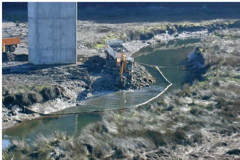
*El empleo de medios para contener la turbidez cuando se realizan trabajos en entornos acuáticos resulta necesario en determinados emplazamientos, y se muestra altamente eficaz*
