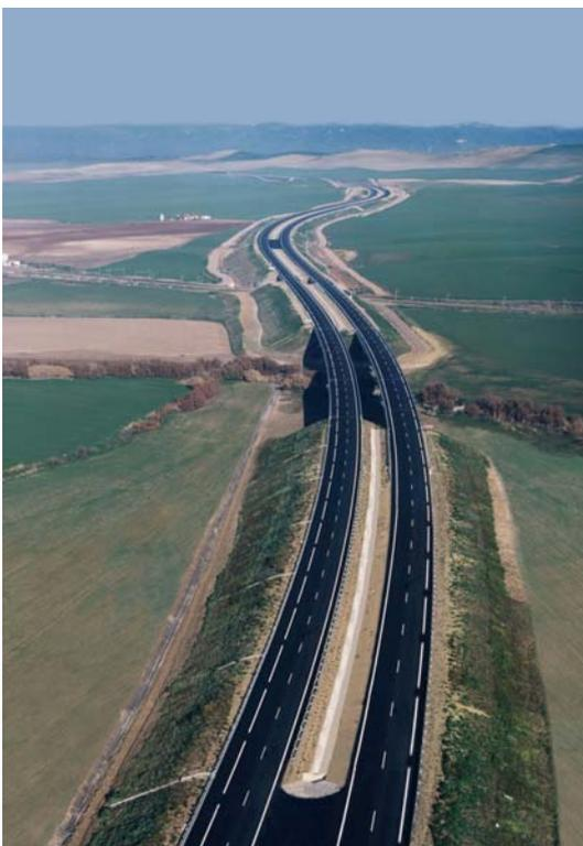
*Las obras lineales suponen siempre una herida en el paisaje, pero un diseño correcto, una integración en la morfología, adecuar el trazado a los elementos geomorfológicos existentes, disminuye la necesidad de desmonte y terraplén y minimiza impactos ambientales*
