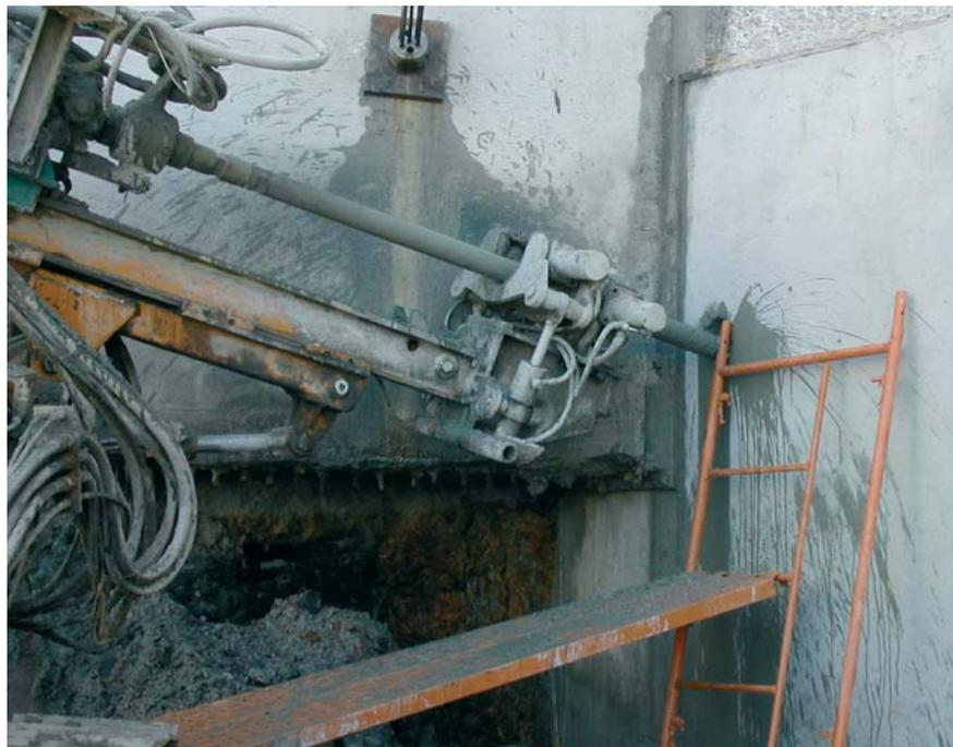
*La perforación por vía húmeda con inyección de agua en el frente y recogida del lodo saliente reduce la generación de polvo*
