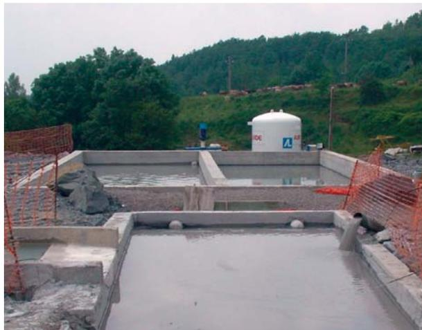
*La salida del efluente se decanta inicialmente antes de pasar a las balsas de neutralización mediante dióxido de carbono situadas a la salida del túnel, eliminando S.S. y reduciendo el pH*
